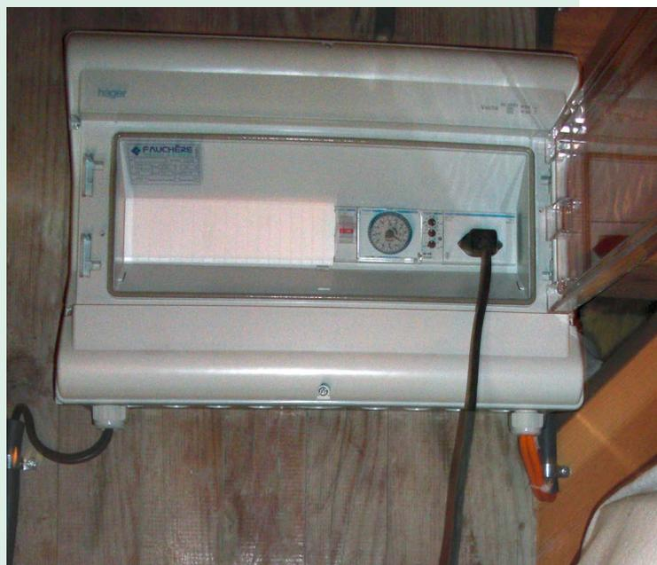
**Pumpensteuerung:** Das Herzstück der Kompostieranlage ist die Pumpensteuerung, welche das Einspritzen der Schotte ins Kompostsubstrat reguliert.
