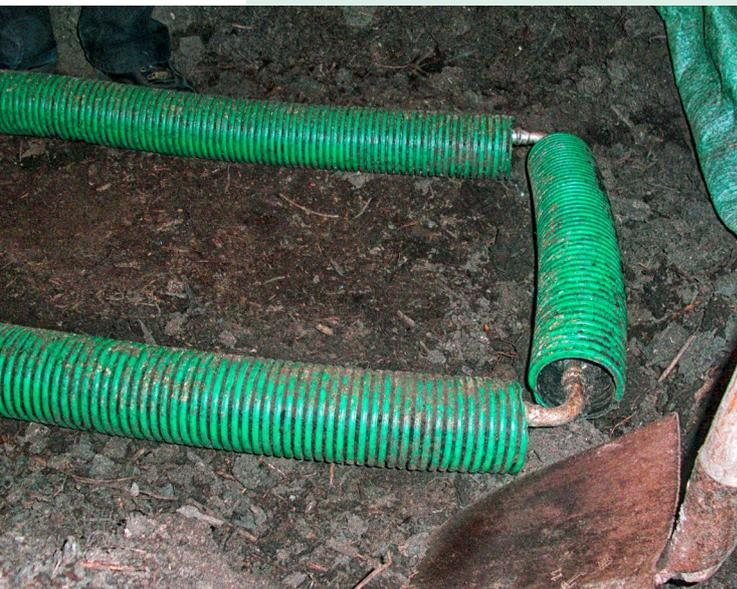
**Verteilrohre:** Über diese Verteilrohre aus Inox wird die Schotte halbstündlich ins Kompostsubstrat eingespritzt. Während des regulären Betriebs sind die Rohre mit einer 20 cm dicken Schicht Kompost bedeckt.
